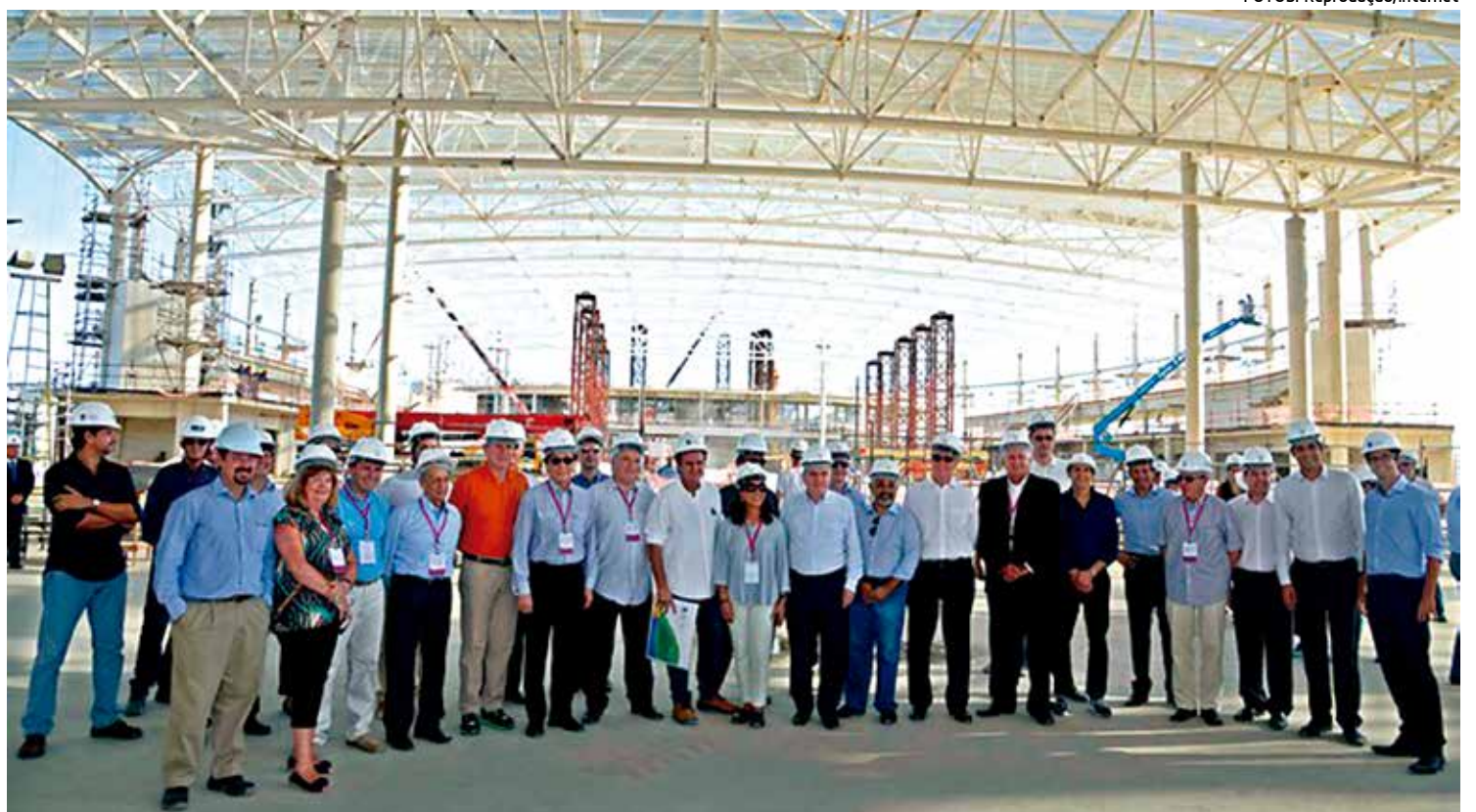
Dirigentes do COI, da Prefeitura e engenheiros em visita às obras no Parque Olímpico que estão adiantadas para a Rio 2016
